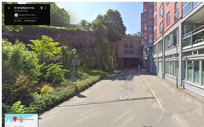
Figur 7. Del av Saltsjöqvarns kaj som leder från kajen till tunneln, sett från norr.
